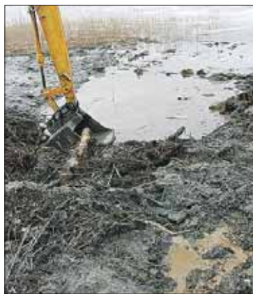
Veden alla olleen putken ympäristö kaivettiin auki korjausta varten.
