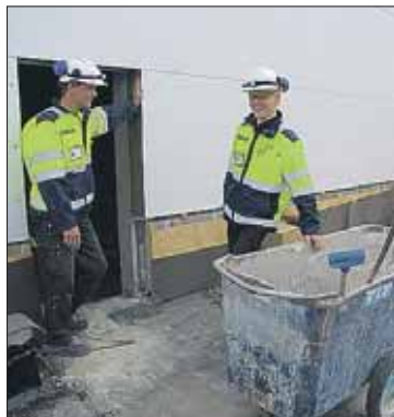
Rakentaminen alkaa vilkastua Rissalan yrityskylässä. Ensimmäisen toimistotalon katolla vastaava mestari Aulis Leskinen ja työmaainsinööri Jari Huttunen.
